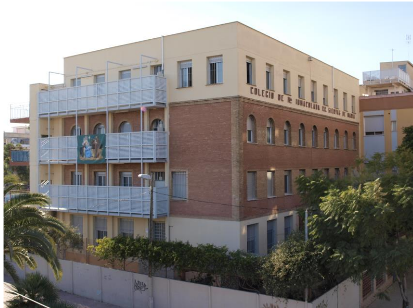
Foto 2: Vista lateral del edificio
